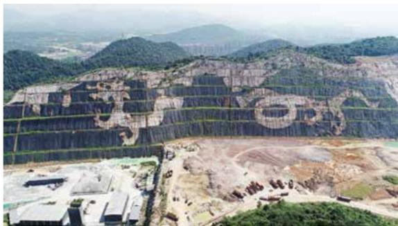
关停。2011年前后,老周又回到了石龙山,还是做爆破工作,但是和以前不同的是,现在的爆破是为了治理矿山。“施工人员在岩壁上钻孔,埋入小剂量炸药,通过一次次精确爆破,将岩壁恢复平整。”矿山整治现场技术负责人刘福高说。
